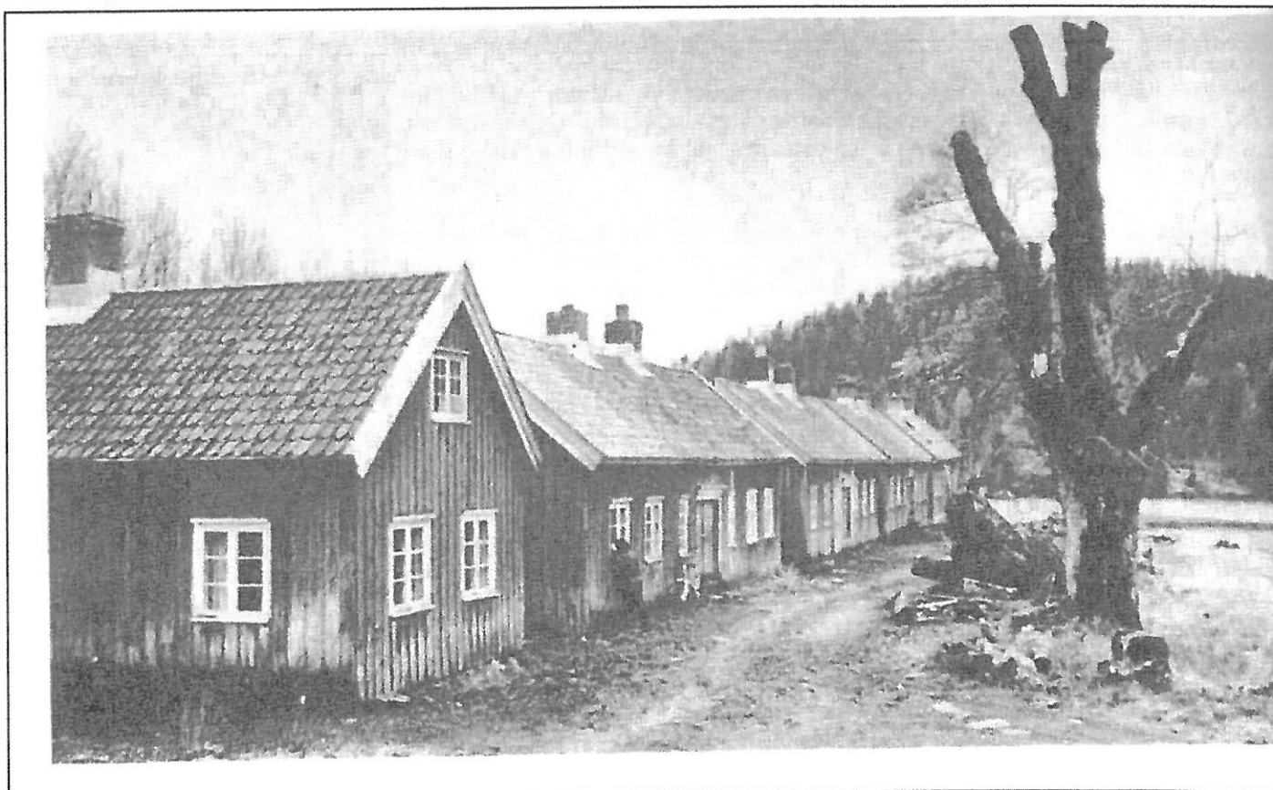
Egeland Verft, Aust-Agder
