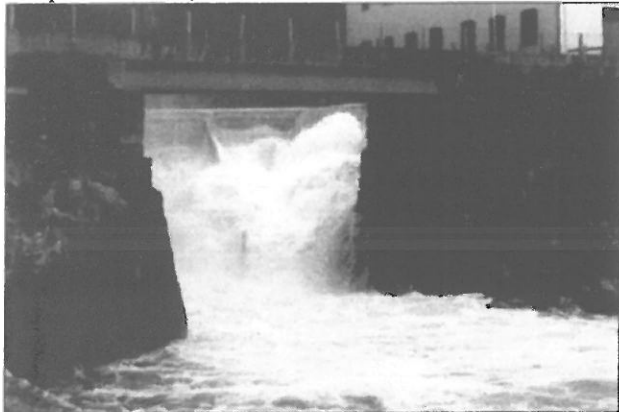
Det var den gode tilgangen de 4 gamle grunnlelementene jord, ild, luft og vann som sørget for at Nes Jernverk kunne holde på i så mange år. Her sees fossefallet ved verket.
