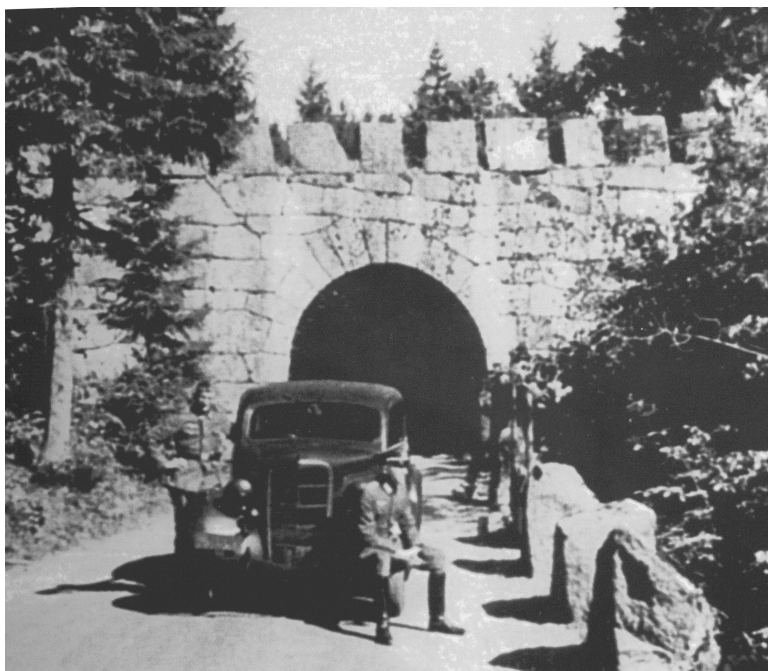
Svingbrua — korketrekkeren Den gamle svingbrua av huggen stein fra 1860 som ble revet og erstattet med betongbru 1941 av tyskerne; av militære årsaker.
